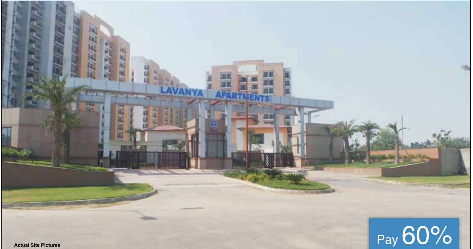
Actual Site Pictures
