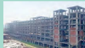
Actual Construction Images
